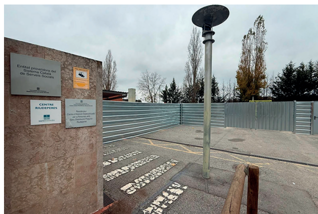
Comencen les obres de reforma i ampliació de la residència Riudeperes
